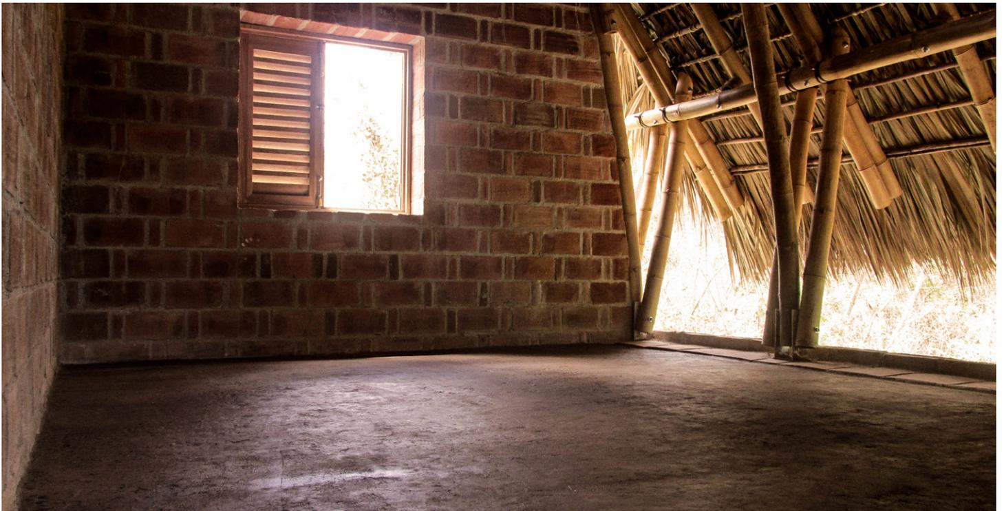
Un workshop réunissant des jeunes architectes et le maître d'ouvrage a permis de réaliser sans machine un sol en terre battue dans la chambre. La terre, gratuite, locale et renouvelable permet la régulation de l'humidité et participe à la qualité de l'air.
